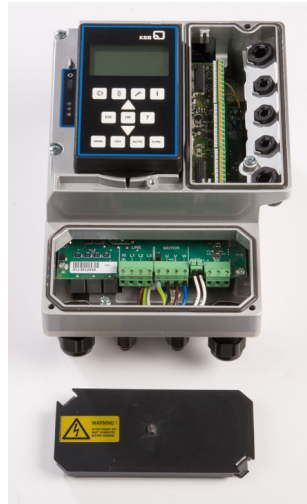
Abb. 12: Schutzabdeckung abnehmen
